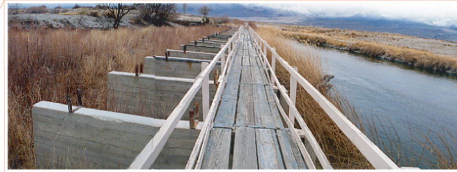
The diversion dam.
